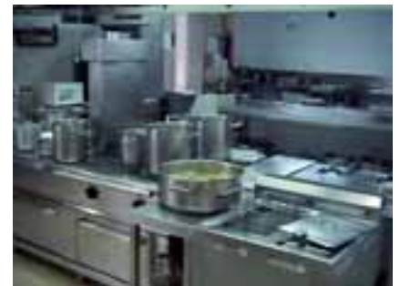
Figura 93 – En las cocinas suelen darse condiciones ambientales desfavorables por calor (cocina) o frío (cámaras).
